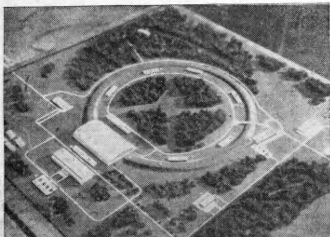
Таким будет крупнейший в мире ускоритель элементарных частиц — Серпуховский протонный синхротрон на 70 миллиардов электронов-вольт. Диаметр кольца синхротрона — 472 м, а длина — 1,5 км.
