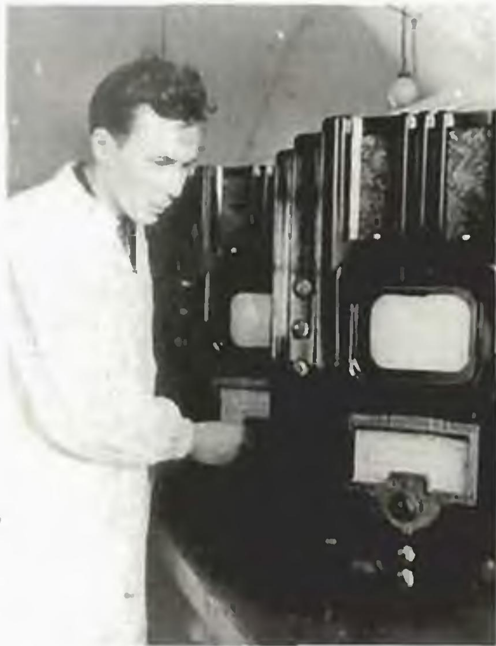
Настройка телевизоров 17ТН-1 в цехе на заводе "Радист"
