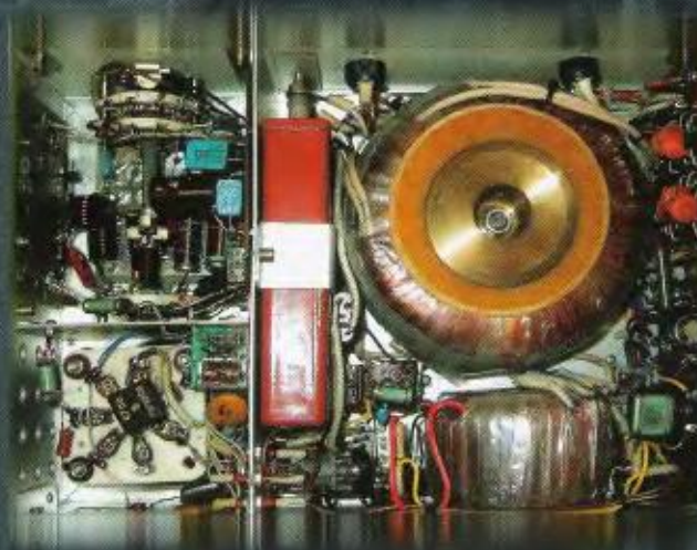
Эти детали усилителя размещены в подвале шасси.
