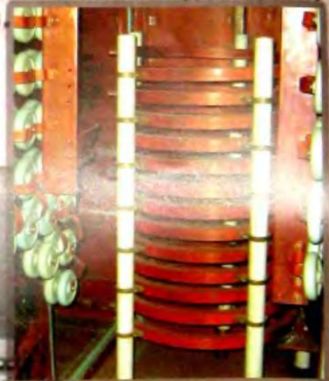
Катушка вариометра средневолнового передатчика.
